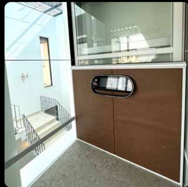
Lắp đặt tại quận Tân Bình, TP.HCM
