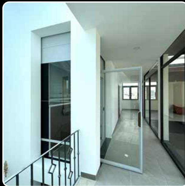
Lắp đặt tại quận Tân Bình, TP.HCM
