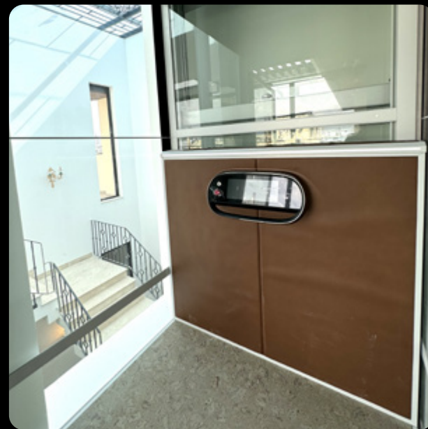
Lắp đặt tại quận Tân Bình, TP.HCM
