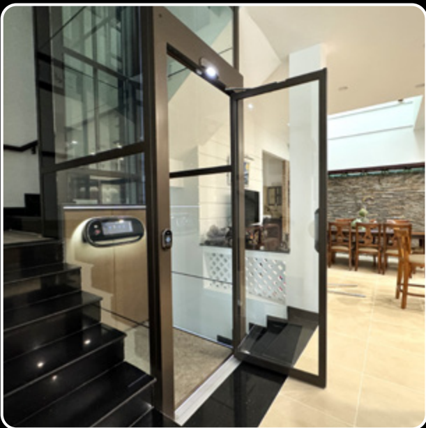
Lắp đặt tại quận 3, TP.HCM
