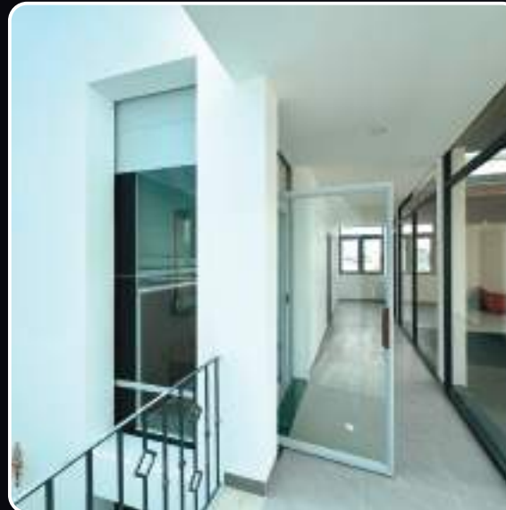
Lắp đặt tại quận Tân Bình, TP.HCM
