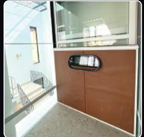
Lắp đặt tại quận Tân Bình, TP.HCM
