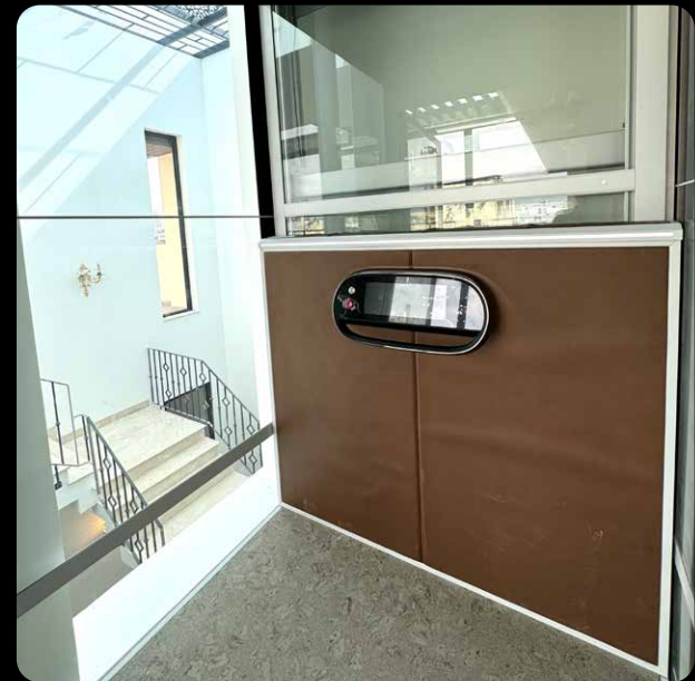
Lắp đặt tại quận Tân Bình, TP.HCM
